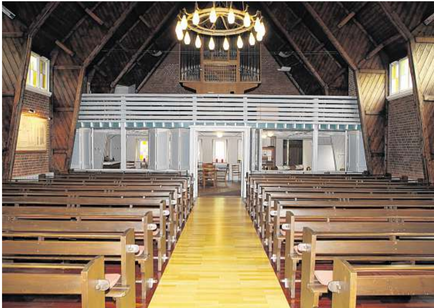
Das Innere der in den Jahren 1948/49 als „Notkirche“ von Kirchenarchitekt Otto Bartning erbauten Andreaskirche an der Lütjenburger Straße mit den Holzfaltfenstern, der Empore und der Orgel. FOTOS: ROLAND SCHEITZ
