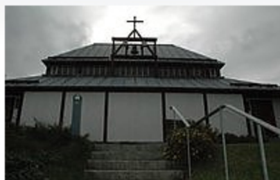
Die Viechtacher Christuskirche wurde 1950 gebaut und zählt zum Typ "Gemeindezentrum" – davon sind noch 16 erhalten. – Foto: Miséré
