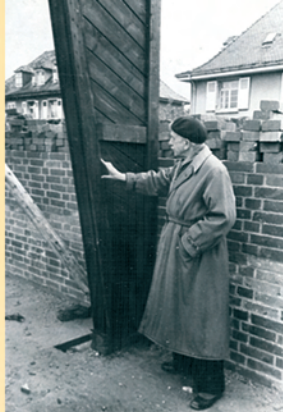
Bartning beim Notkirchenbau in Pforzheim
