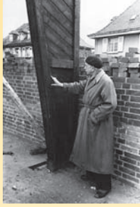
Bartning beim Notkirchenbau in Pforzheim
