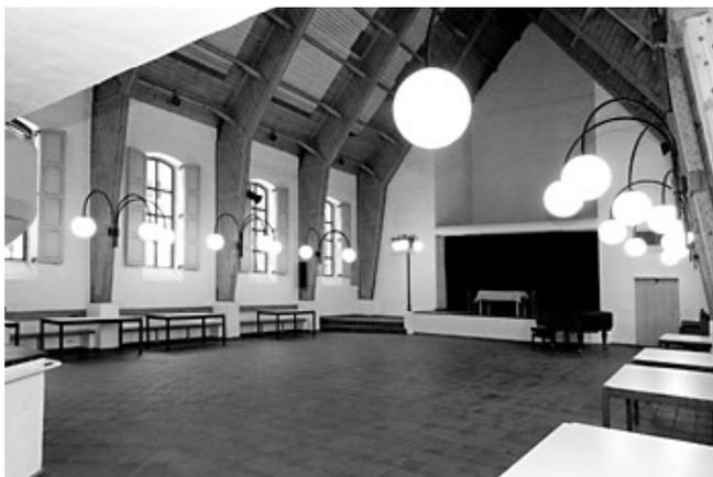
■ Die alte Münchner Kreuzkirche dient heute als Gemeindesaal: Als Leiter der Bauabteilung des Evangelischen Hilfswerks entwickelte Otto Bartning ein System vorgefertigter Holzelemente, die zu einem Kirchenschiff zusammengesetzt und mit Trümmersteinen ausgefüllt wurden. Die in Serie gefertigten hölzernen »Bartning-Binder« sind bis heute in vielen Kirchen zu sehen. Sie ermöglichten kostengünstig einen aufstrebenden, hohen Kirchenraum.
