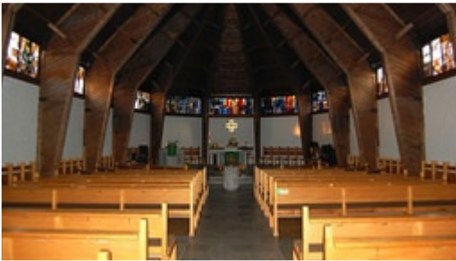
Das sogenannte "Zeltdach" ist charakteristisch für die "Bartning-Notkirchen".
